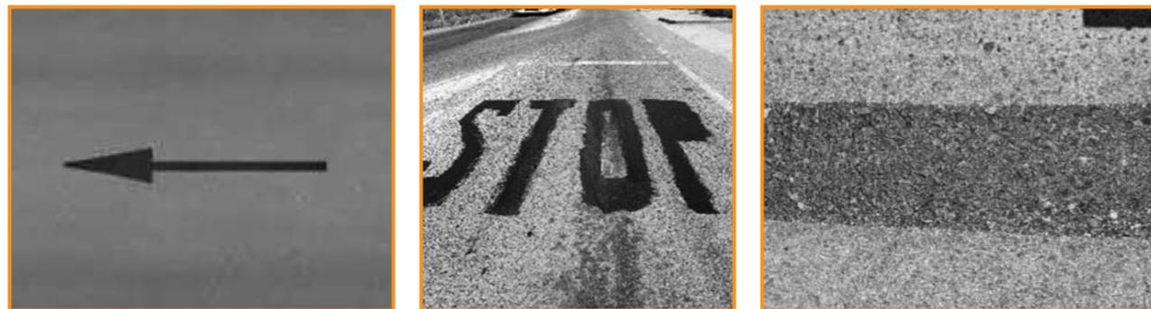
**Figura 9.-** Ejemplos de señales sobrepintadas de negro y borradas con hidrolimpiadoras.
