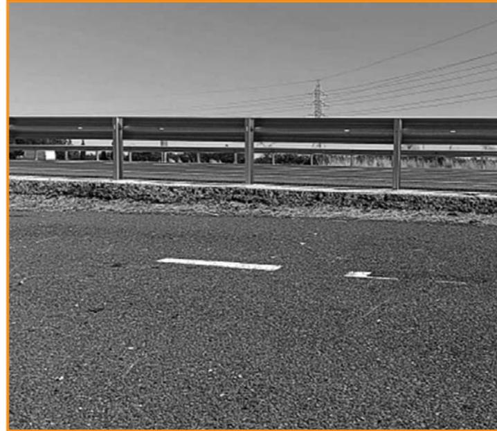
Figura 15.- Borrado de señal sin cambio de textura.
