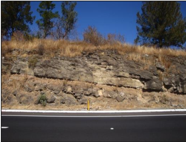
Imagen 5.10 Corte 295 + 600 cuerpo A. Suelo Sedimentario.
