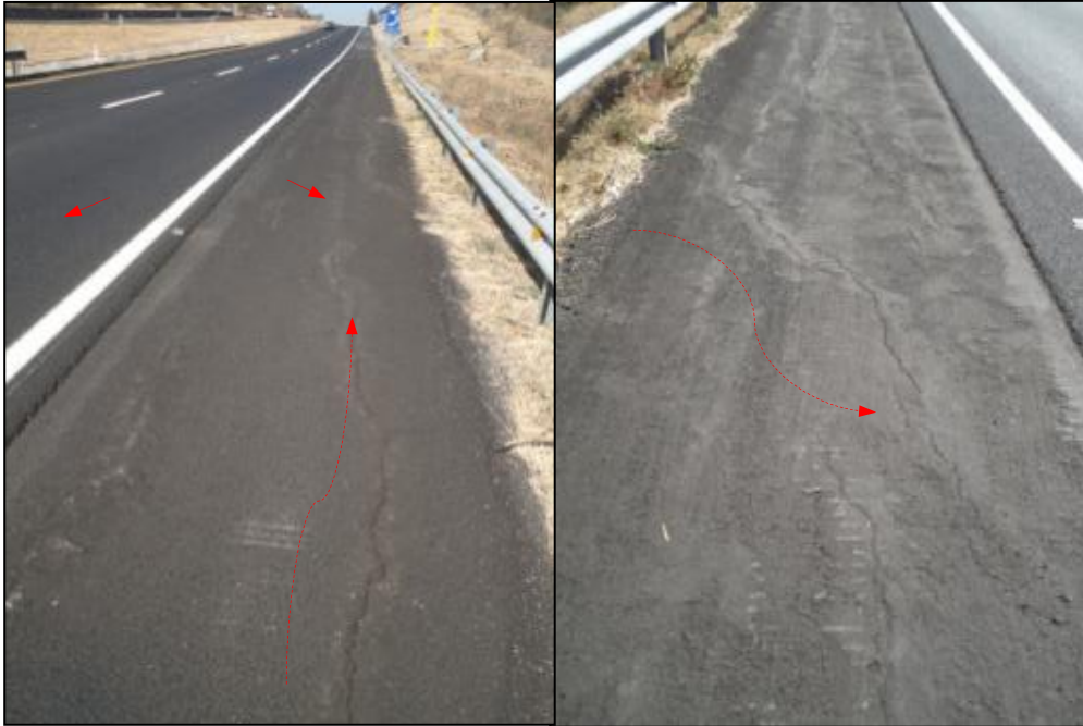
Imagen 5.3. Capa de rodamiento del terraplén km. 430+650
