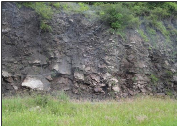
Imagen 5.8.- Corte 262 + 200 cuerpo B. Bloques en matriz de suelo: IG_{ECC} = 615
